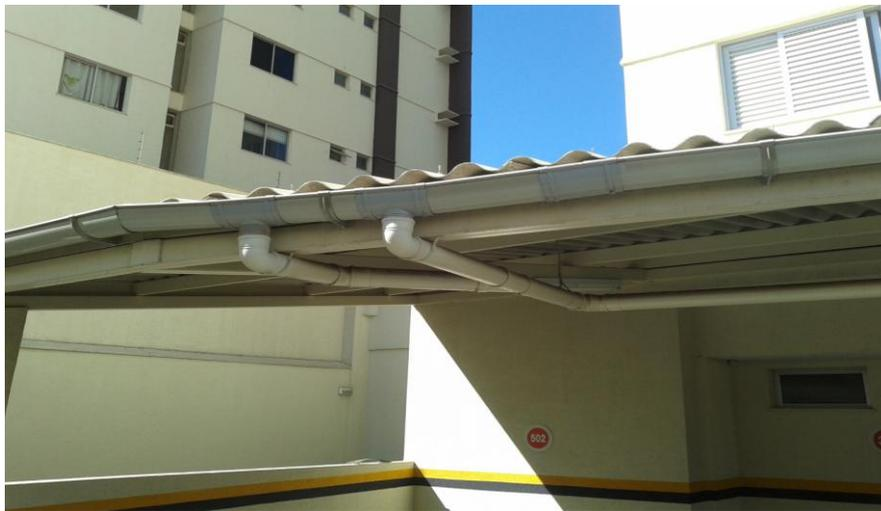
**Figura 1-** Captação da água no telhado da edificação.
